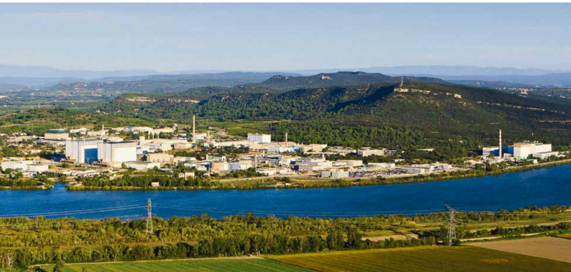
Au bord du Rhône, le site de Marcoule, berceau du nucléaire industriel français. Créé dans les années 50, il réunit aujourd'hui une concentration sans équivalent de chantiers de démantèlement. © CEA/LE COUSTER
