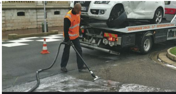
Help! fait travailler les enzymes pour dévorer les hydrocarbures polluant la chaussée.
